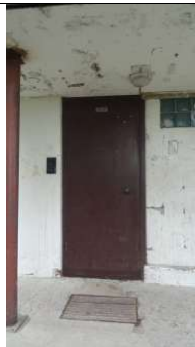
Kāpņu telpas ārdurvis
